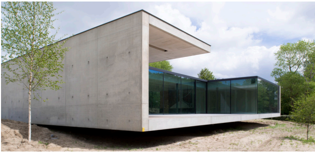
Zelfverdichtend beton omhult perfect moeilijke bekistingsuitsparingen en andere details
