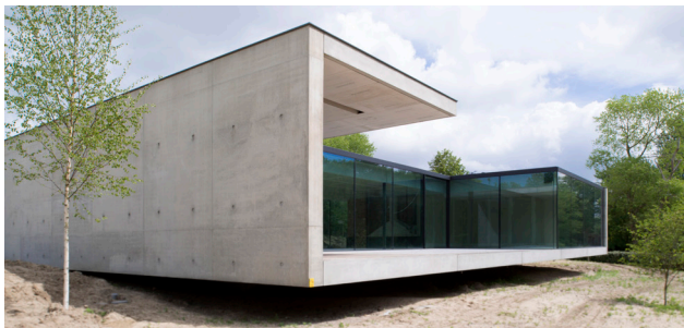
Le béton autocompactant remplit parfaitement les formes et détails complexes
