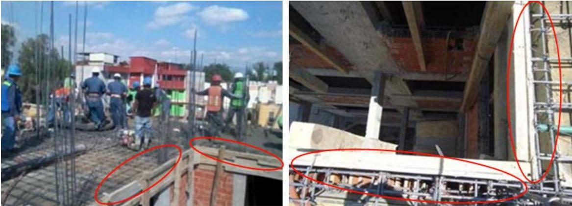
Figure K6 : Des photos de chantier montrent le manque de protection latérale, des EPI pour le travail en hauteur et des obstacles sous les pieds représentent un risque de chute.
