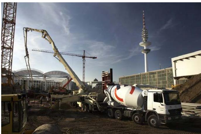
Figure B1 : Pompe à béton mobile
