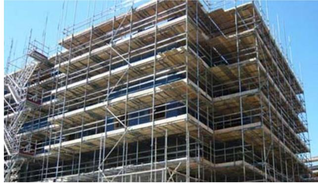
**Figure 4 : Exemple d'un bon échafaudage avec des escaliers d'accès et une protection latérale tout autour**
