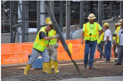
Figure 31 : Zone de danger du tuyau de refoulement
