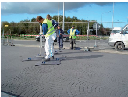
Het stempelen van printbeton is een precisiewerk die u best aan een ervaren aannemer overlaat
