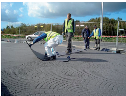
Het stempelen van printbeton is een precisiewerk die u best aan een ervaren aannemer overlaat
