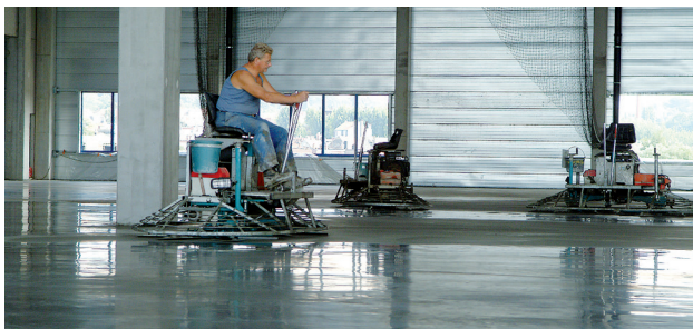
Het polieren en inzagen van beton vergt ervaring en vakmanschap.
