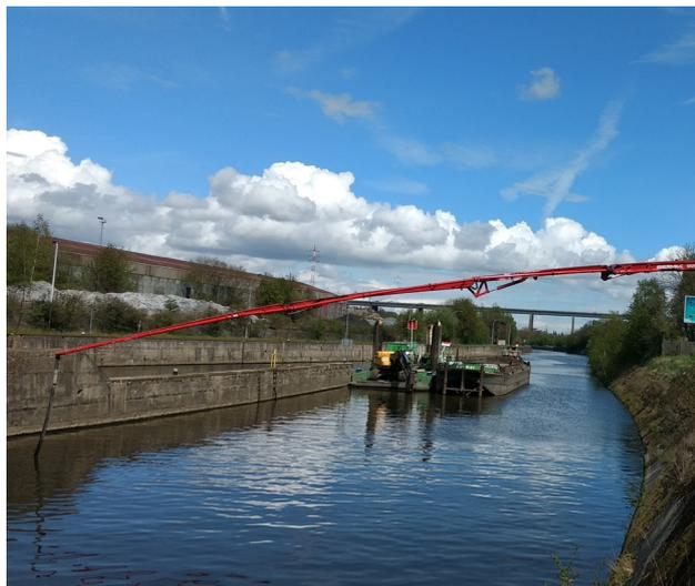
L'AQUAROC est particulièrement adapté aux bétonnages dans l'eau ou au bord de l'eau
