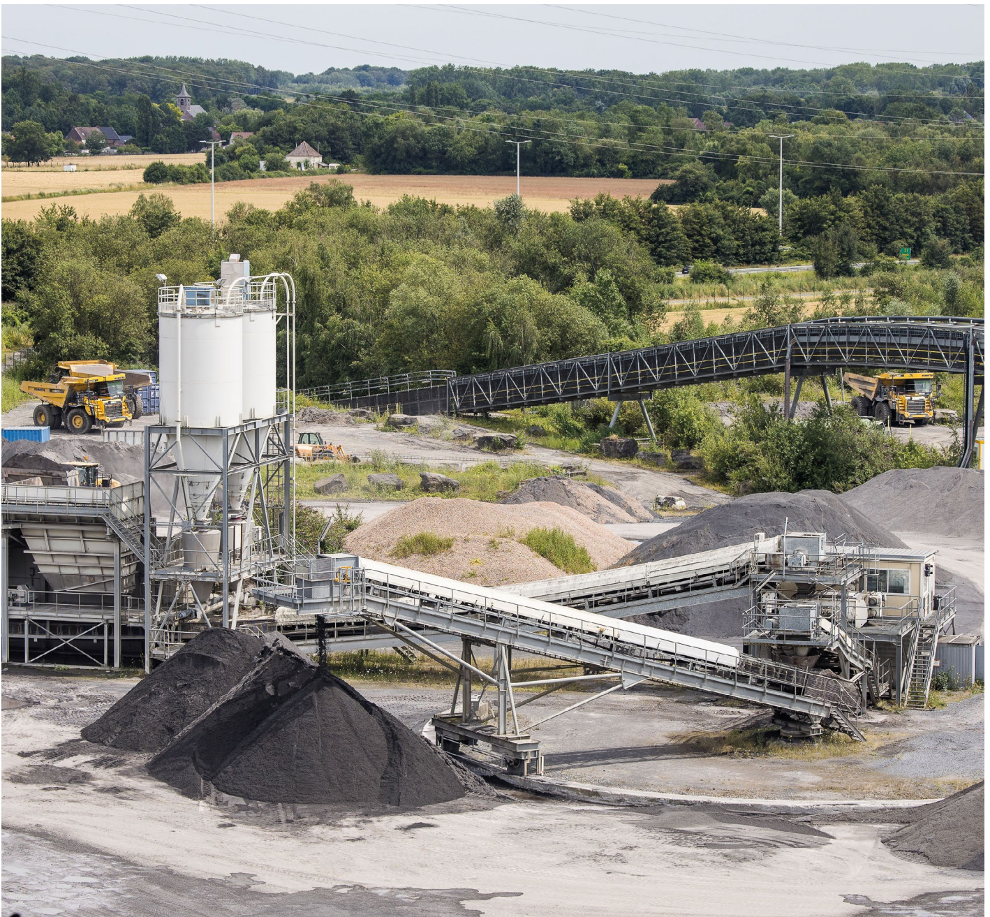
Ternaire centrale in de groeve van Milieu van Holcim België
