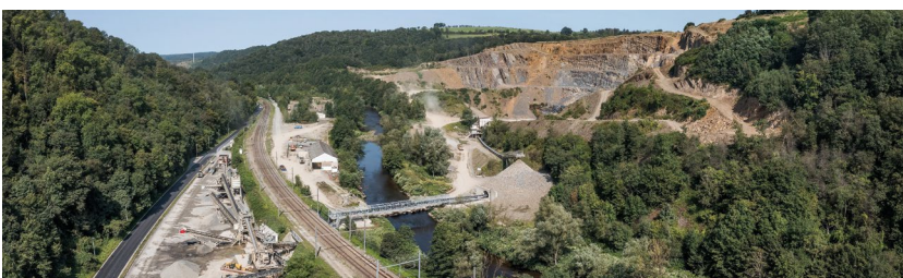
Groeve langs de weg, het spoor en de rivier Vesdre
