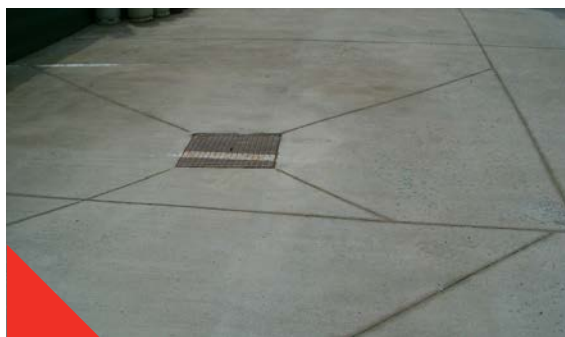
Fig 4.2.7 Maîtrise des effets du retrait par fractionnement
