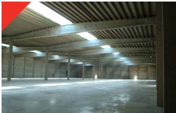
Fig 3.6.1 Poutres longues portées en BHP
