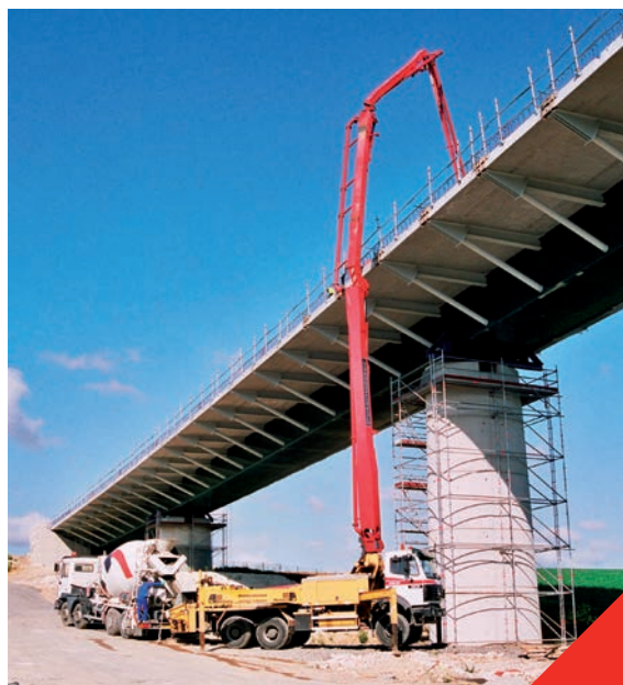
Fig 2.6.1 Mise en place du béton par pompage
