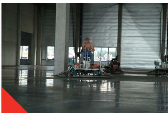
Fig 3.1.1 Finition à l'hélicoptère
