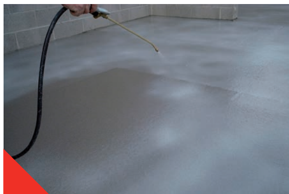
Fig 3.2.9 Vaporizzazione di un prodotto di cura
