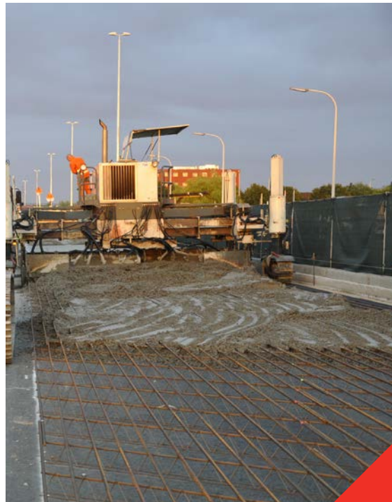
Fig 3.5.6 Béton armé continu en cours de coulage
