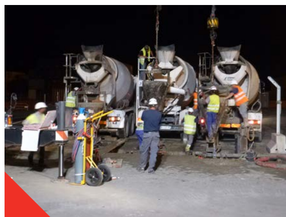
Fig 3.7.4 Coulage d'un panneau de paroi moulée
