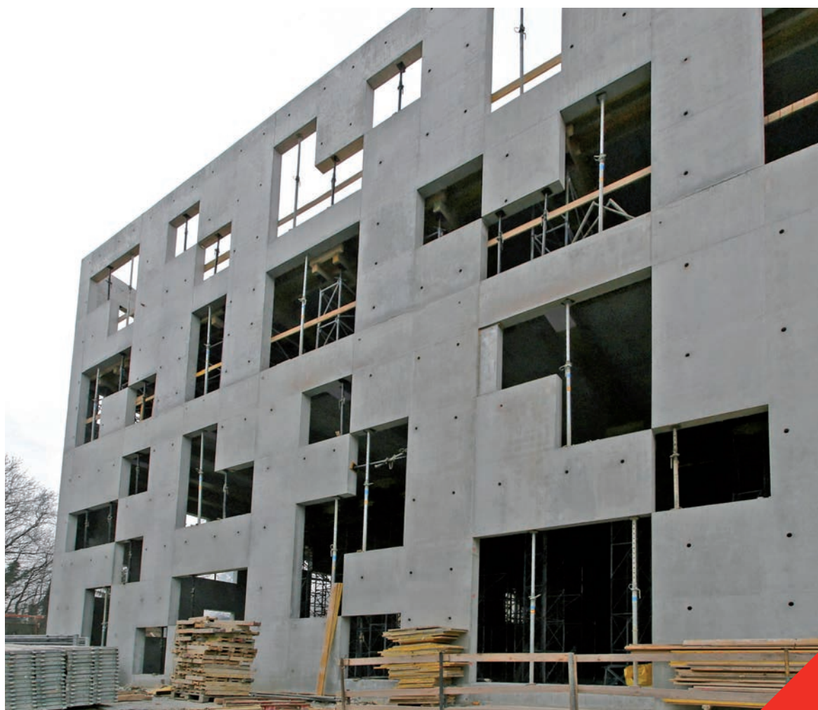
Fig 3.2.10 Le BAP a permis la réalisation sans difficultés des formes complexes en réduisant les étapes de bétonnage
