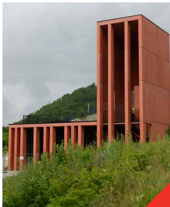
Fig 3.4.11 Bâtiment en béton coloré
