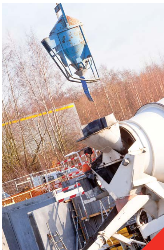
Fig 2.7.1 Mise en œuvre d'un béton au cufa
