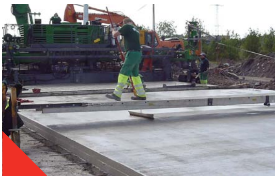
Fig 3.5.3 Brossage du béton en surface
