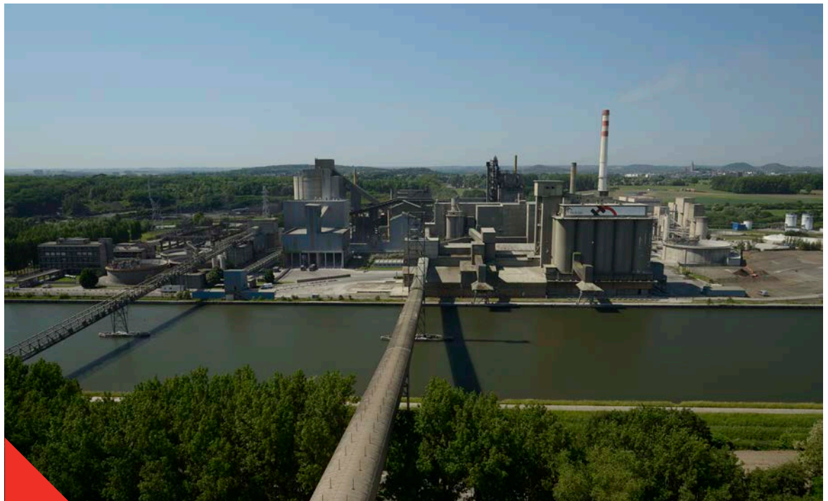
Fig 1.1.1 Vue générale d'une cimenterie
