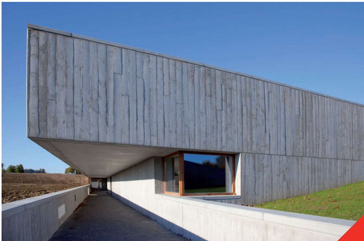
Fig 3.4.3 Structure matricée du voile obtenue par un coffrage en planches de bois
