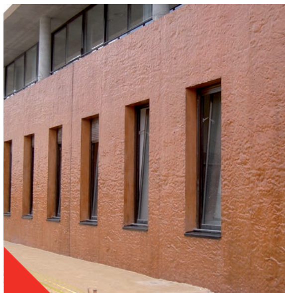
Fig 3.4.1 Béton coloré coulé dans un coffrage matrice
