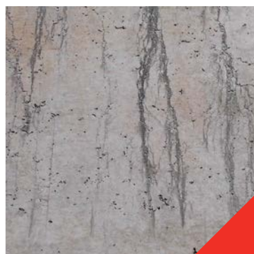
Fig 4.1.2 Veines de sable
