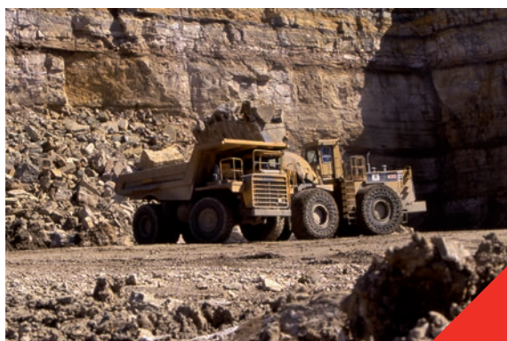
Fig 1.1.2 Engins à l'oeuvre dans une carrière
