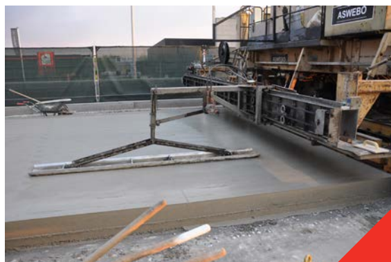
Fig 3.5.2 Lissage automatique du béton
