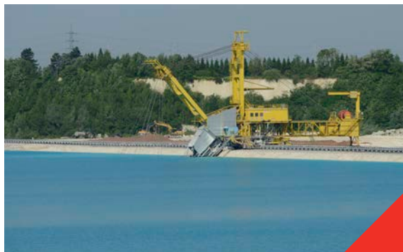
Fig 1.1.3 Extraction de la craie sous eau
