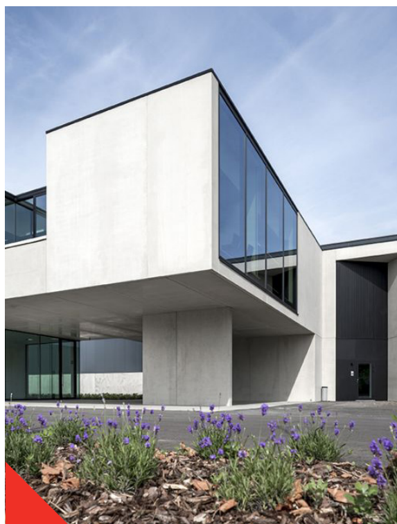
Fig 3.4.2 Façade en béton apparent brut
