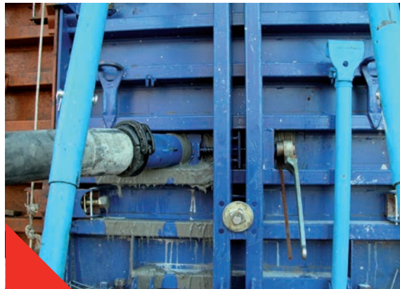
Fig 3.2.6 Pompaggio del cemento autoplaçante per il basso del formo
