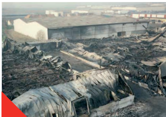
Fig 4.10.2 Un bâtiment a été sauvé grâce au mur de béton
