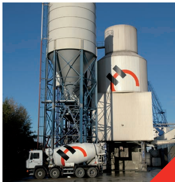
Fig 2.4.4 Centrale à béton
