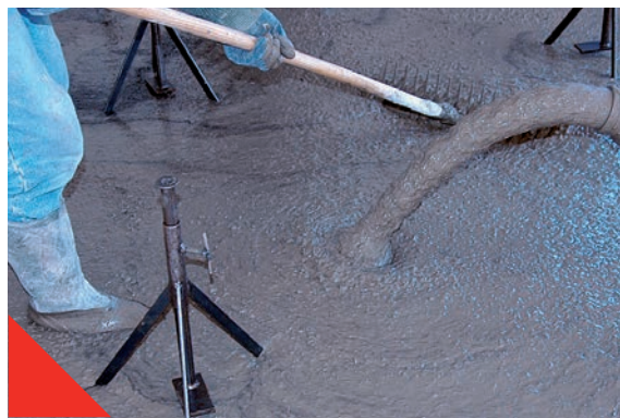
Fig 3.2.7 Impiego del cemento autoplaçante (chape auto- riparante) su una superficie orizzontale
