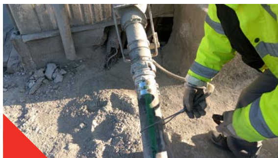
Fig 5.2.1 Placement du câble anti coup de fouet
