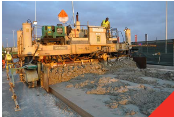
Fig 3.5.1 Machine à coffrage glissant
