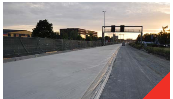
Fig 2.8.6 Cure par couverture plastique
