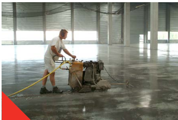
Fig 3.1.5 Sciage des joints de retrait
