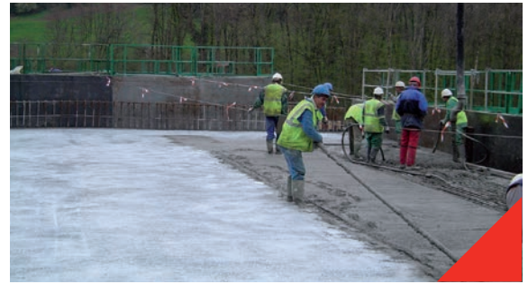
Fig 2.8.5 Un produit de cure coloré permet de mieux contrôler l'application
