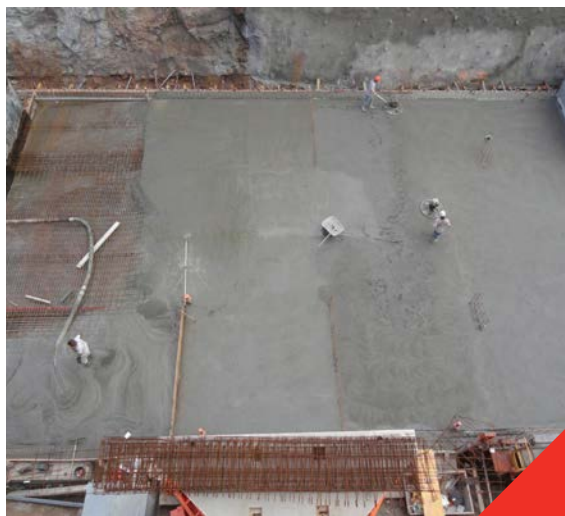
Fig 3.1.3 Dallage en cours de réalisation
