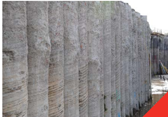
Fig 3.7.1 Paroi réalisée avec des pieux forés sécants
