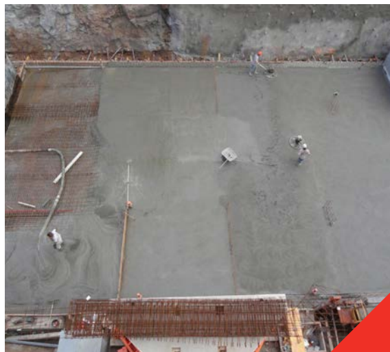
Fig 3.1.3 Betonvloer in volle uitvoering
