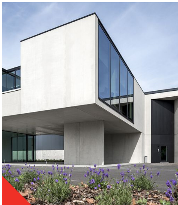
Fig 3.4.2 Gevel in ontbewerkt zichtbeton
