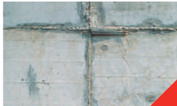
Fig 2.5.2 Effect van bekistingsvoegen die onvoldoende dicht zijn
