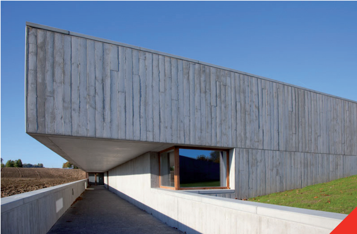
Fig 3.4.3 Bijzondere textuur van het oppervlak dankzij het gebruik van een bekisting in houten planken
