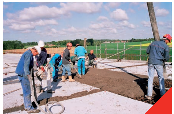
Fig 4.2.4 Het later betonneren van "sluitmooten" bij een betonvloer
