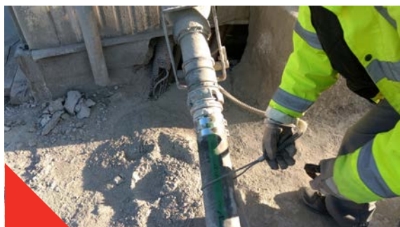
Fig 5.2.1 Plaatsing van de anti- terugslagkabel
