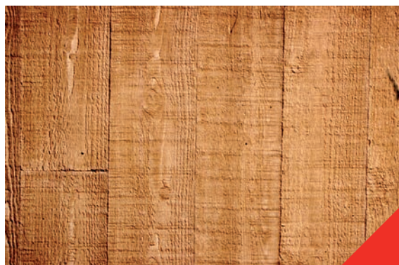
Fig 2.5.4 Geslaagd betonoppervlak: bekisting met ruwe houten planken
