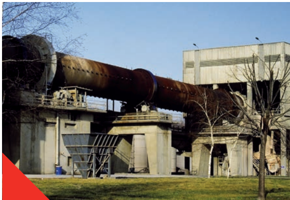
Fig 1.1.4 Draaioven, het hart van de cementfabriek
