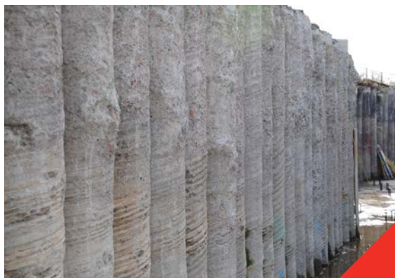
Fig 3.7.1 Wand uitgevoerd in secans boorpalen
