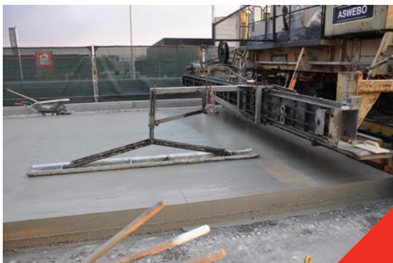
Fig 3.5.2 Automatisch gladstrijken van het beton
