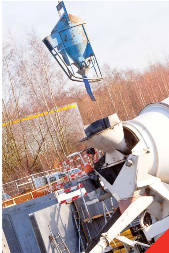
Fig 2.7.1 Storten van beton met de kubel
