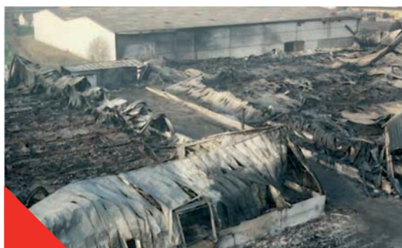
Fig 4.10.2 Dankzij een brandmuur in beton werd een gebouw gespaard
