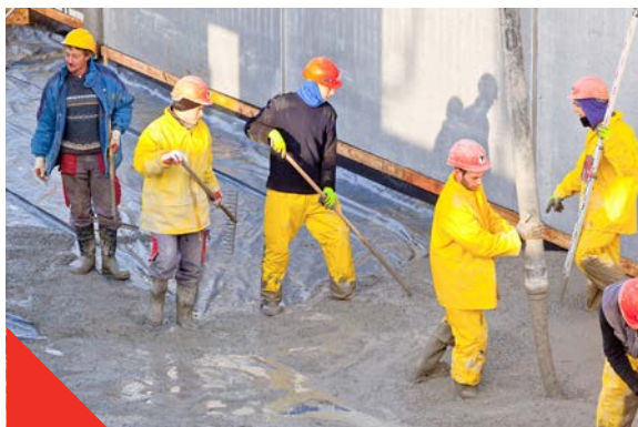
Fig 5.2.4 Risicozone rond de aanvoer- leiding
