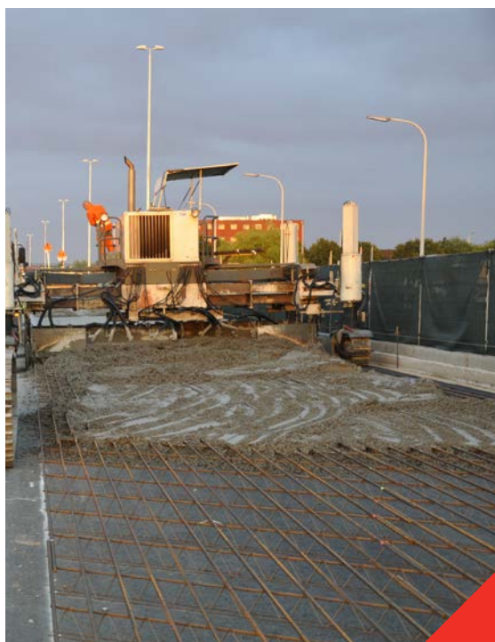
Fig 3.5.6 Doorgaand gewapend beton tijdens de uitvoering
