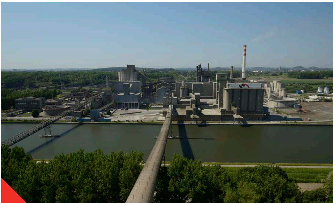
Fig 1.1.1 Algemeen beeld van een cementfabriek
