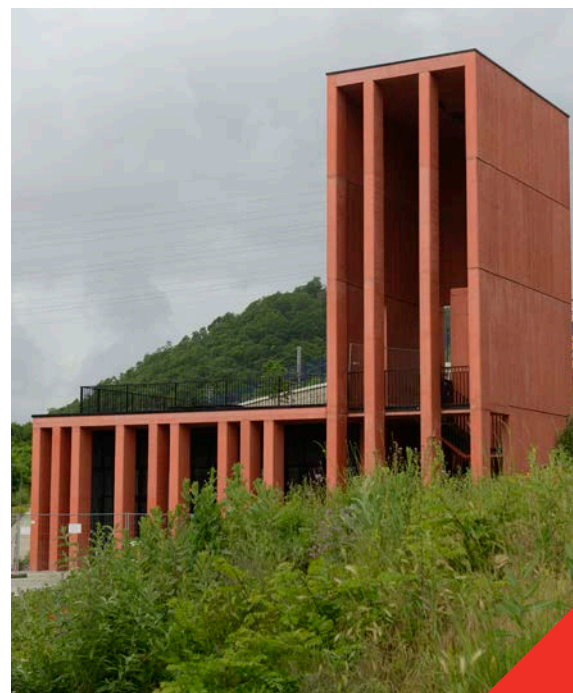
Fig 3.4.11 Gebouw in gekleurd beton
