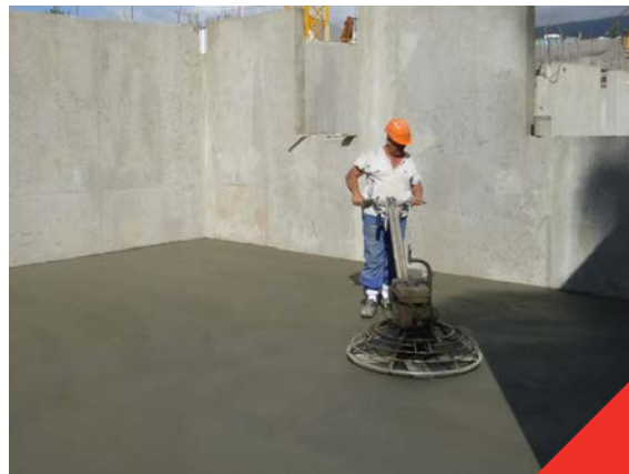
Fig 3.1.2 Afwerking met een "helikopter"
