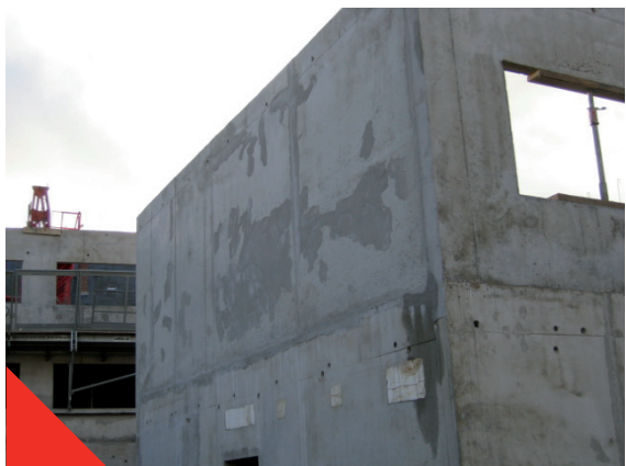
Fig 2.5.7 Kleurverschillen in een betongevel te wijten aan een slechte verdeling van het ontkistingsmiddel
