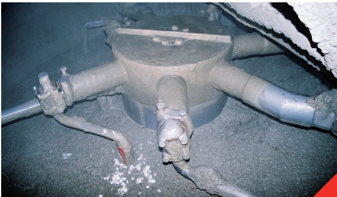
Fig 2.4.1 Zicht binnen in een menger van een beton- centrale
