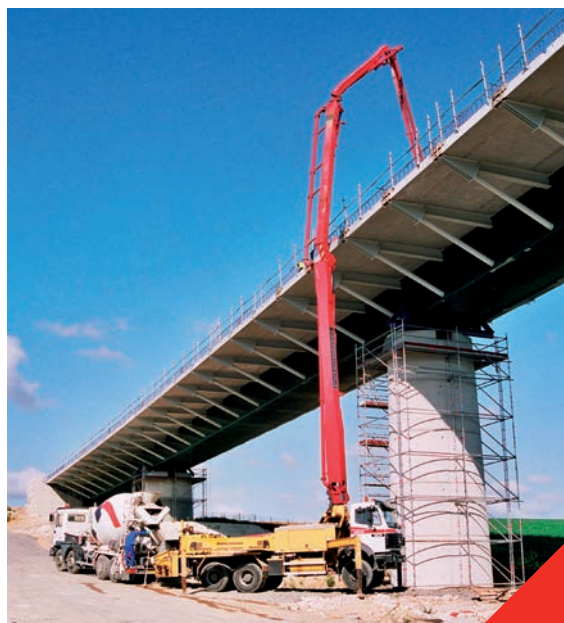
Fig 2.6.1 Storten van beton met een betonpomp
