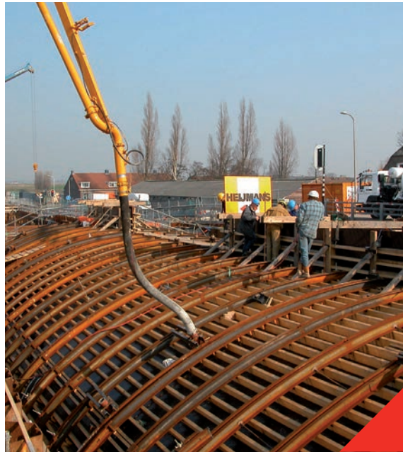
Fig 3.2.5 ZVB laat probleemloos toe concave vormen te maken zonder hernemingen en met een mooie afwerking
