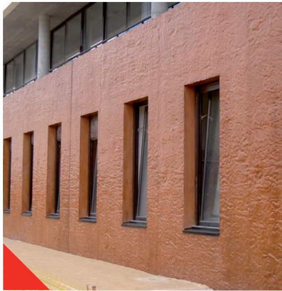
Fig 3.4.1 Gekleurd beton gegoten in een mal met structuur- matten
