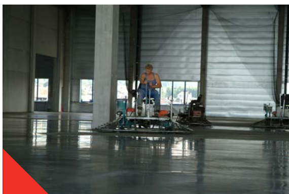
Fig 3.1.1 Afwerking met een "helikopter"
