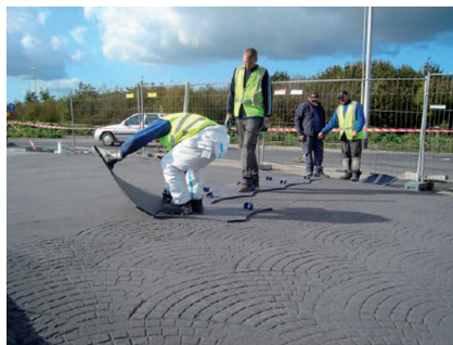
L'impression du béton est un travail de précision qu'il est préférable de confier à un entrepreneur spécialisé
