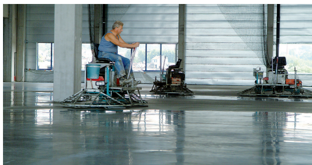
Le polissage et le sciage du béton requièrent expérience et expertise.
